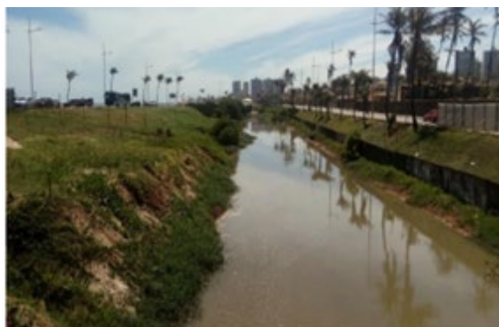
Figura 04. Rio Jaguaribe antes canalização
