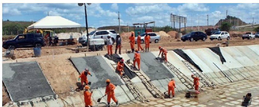
Figura 02 – Trecho da obra de canalização do Rio Jaguaribe em 2019
