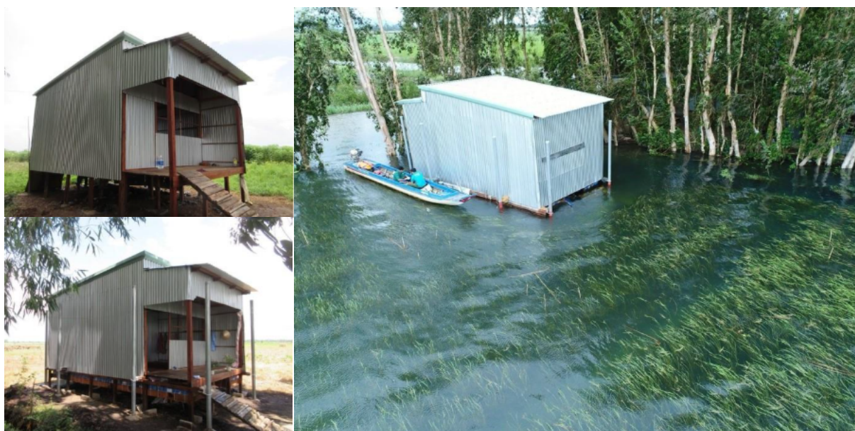
Figura 24 – Retrofit de casa no Delta do Rio Mekong, Vietnã.
