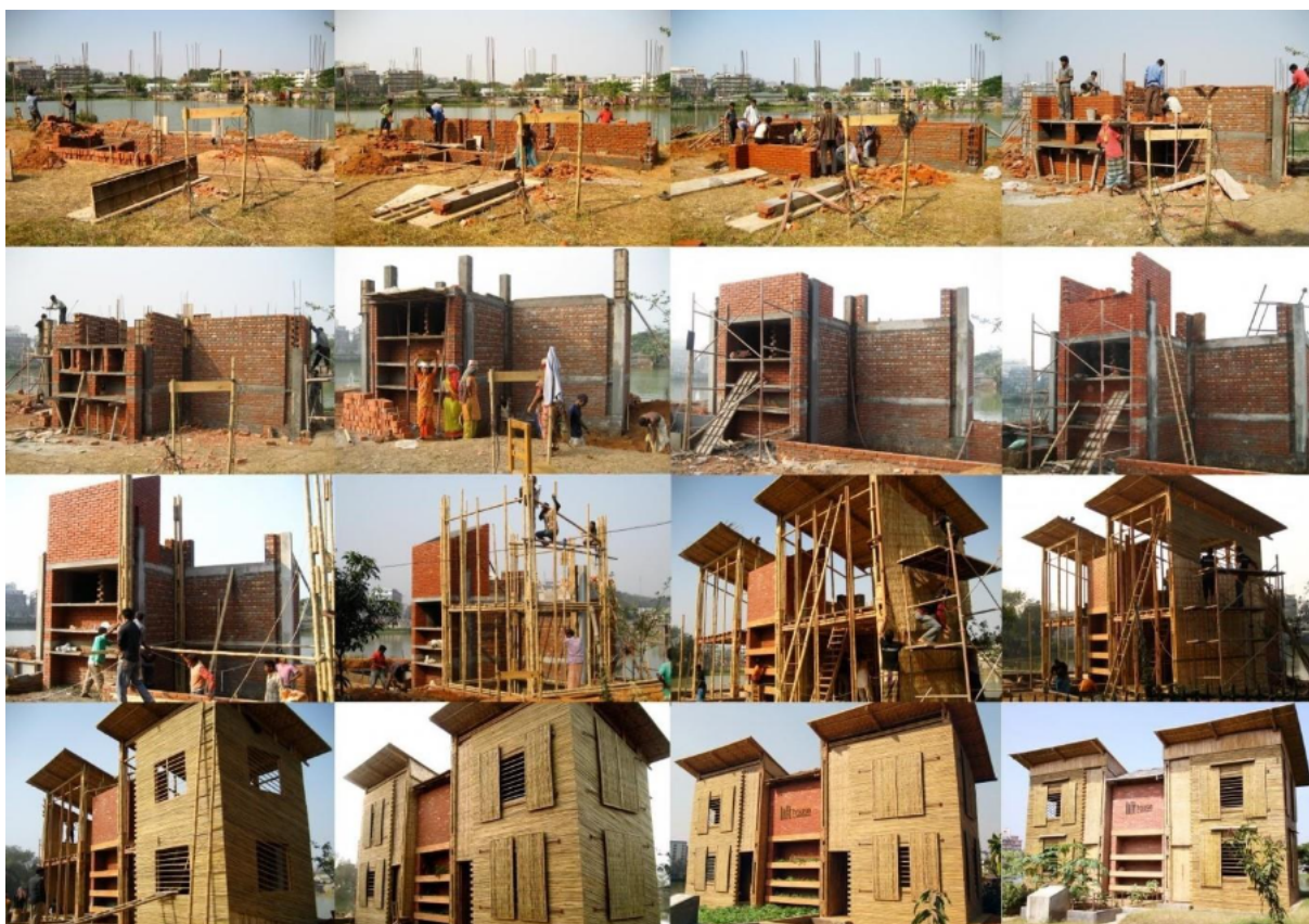
Figura 23 – Processo construtivo da Casa Lift, em Daka, Bangladesh.
